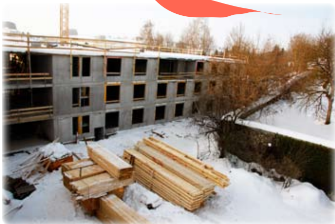
Bild oben: 1. Holzlieferung für den Dachstuhl liegt vor dem Rohbau in Gramastetten.
